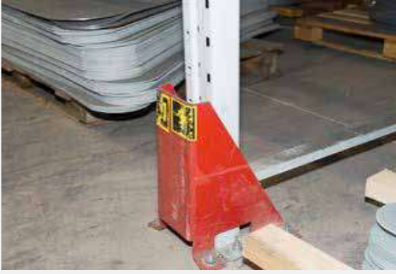
Şekil A.6.11: Kolon muhafazası örneği
