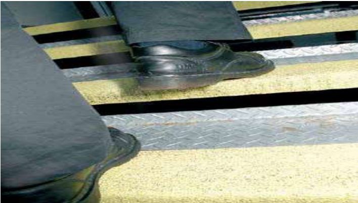
Şekil A.6.6: Kaymaz zemin kaplamalı merdiven örneği
