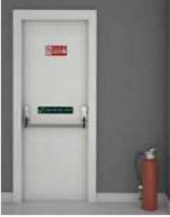
Şekil A.11.1: Acil çıkış kapılarının işaretlenmesi
